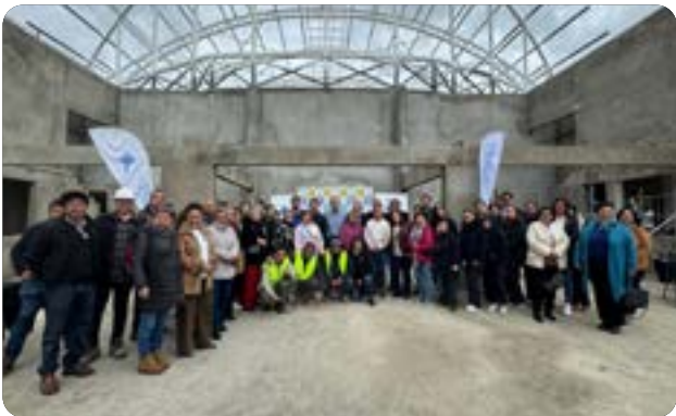
El mes de agosto se realizaron los tijerales del Gimnasio Municipal, obra que es financiada por Aguas Pacífico.
